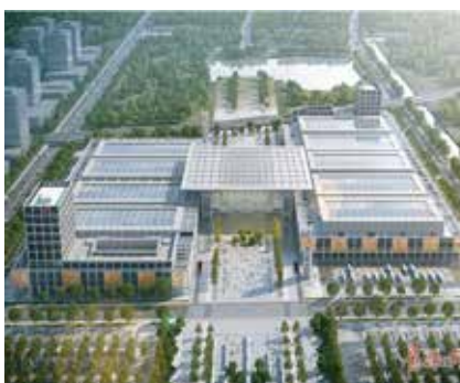
红岛会展中心 204套室内地面自由安装污水提升泵站
