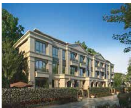
上海御宫艺墅 350套室内地面自由安装污水提升泵站
