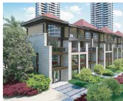
雅居乐 海口清水湾 683套室内地面自由安装污水提升泵站
