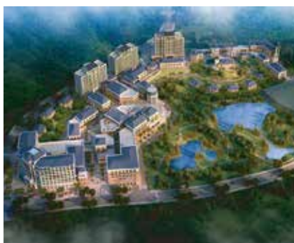
三亚温泉谷度假养生中心一期 300套室内地面自由安装污水提升泵站
