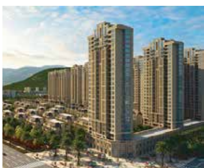
台州翠屏春晓别墅 140套室内地面自由安装污水提升泵站
