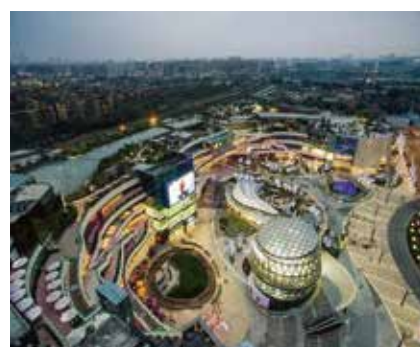
成都大悦城 10套室内地面自由安装污水提升泵站
