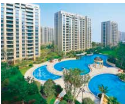
杭州绿城凤起朝鸣 53套室内地面自由安装污水提升泵站
