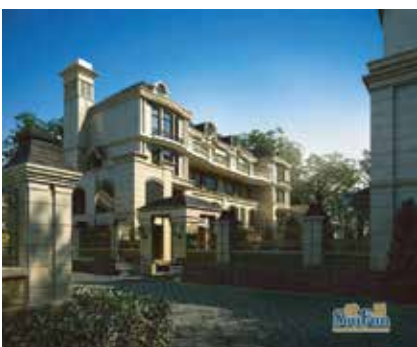
绿地集团新南路法式宫廷别墅区 378套室内地面自由安装污水提升泵站
